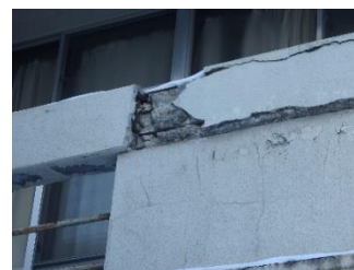
バルコニー手摺の欠損および鉄筋の露出
